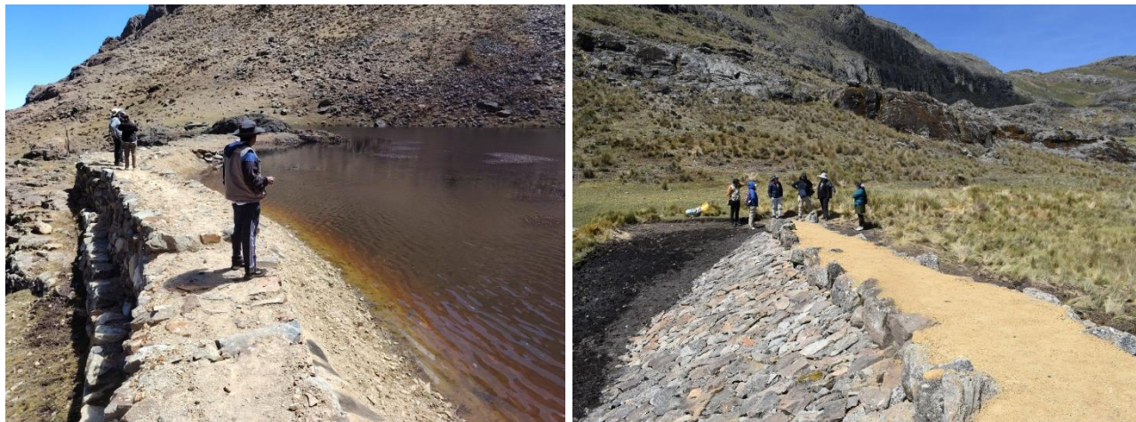
Diques prehispánicos rehabilitados de Wetacocha en Pamparomás, Huaylas (izquierda) y de Shuclluyoc en Cajamarquilla, Huaraz (derecha)
