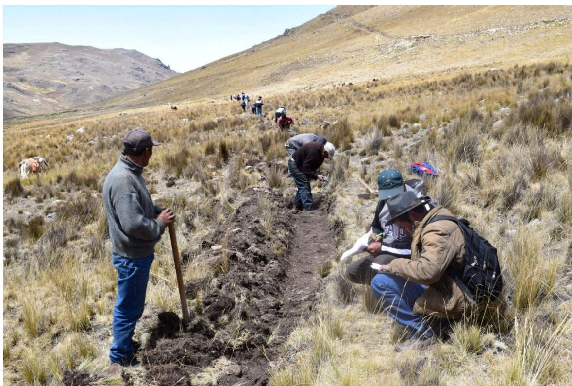
Faena de construcción de amuna o canal amunero en el sector de Ampirá (La Merced, Aija).
